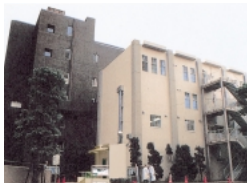
5号館 Building No.5
