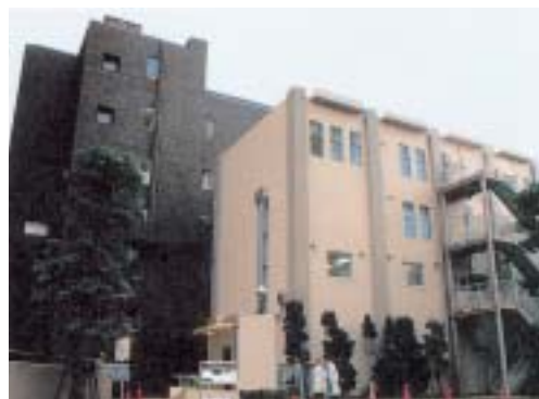
5号館 Building No.5
